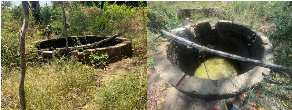
Fotos do poço artesiano
